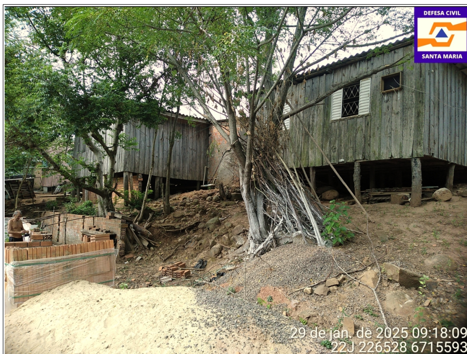
Foto 9: Vista dos fundos das mesmas casas apresentadas pela Foto 8. É possível notar que há casas construídas imediatamente abaixo do talude que sustenta as residências em risco. Há claros sinais de carreamento de solo no local, tornando a área instável e colocando em risco de desabamento as residências ali construídas.
