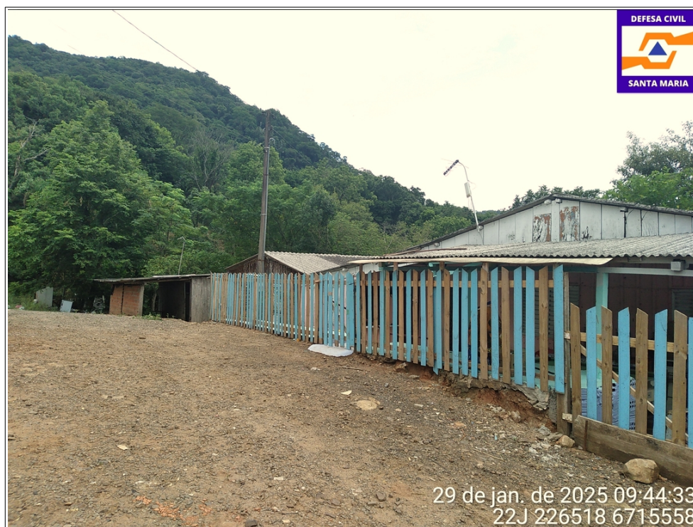
Foto 1: Frente das três últimas casas do lado leste do patamar superior da Rua Rodrigues Alves, junto a esquina da Rua Humaitá. Nota-se pela imagem que as casas foram construídas em patamar inferior ao nível da Rua Rodrigues Alves, em processo de corte e aterro realizados para execução de terraplenagem dos terreno aos fundos das casas em questão.
