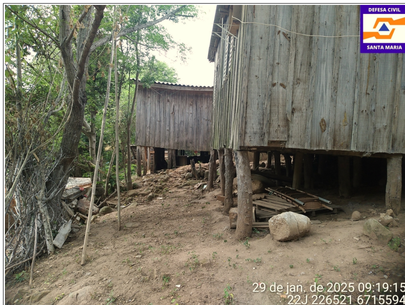
Foto 8: Aspecto das fundações das residências de madeira, que estão imediatamente posicionadas a norte da casa de número 361. Ambas as casas encontram-se desocupadas, atualmente.
