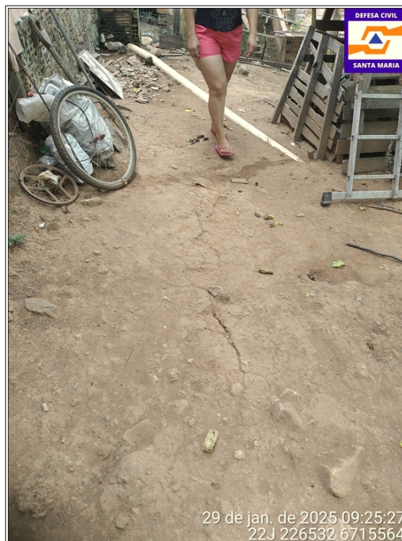
Foto 6: Ocorrência de sinais incipientes de abertura de trincas no solo, aos fundos da casa de número 361.
